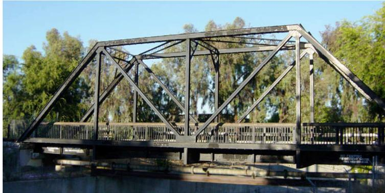
**Définition :** Un **système réticulé (ou treillis)** est un système composé de barres droites articulées entre elles à leurs extrémités.
