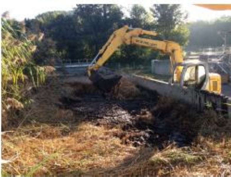
Curage sur casier béton (crédit photo : Alliance Environnement)
