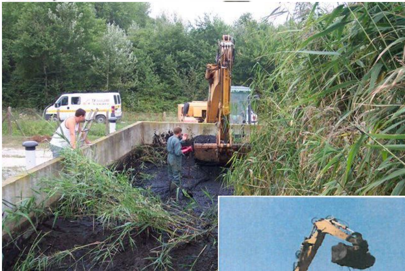
Curage sur casier déblais-remblais (crédit photo : Irstea)
