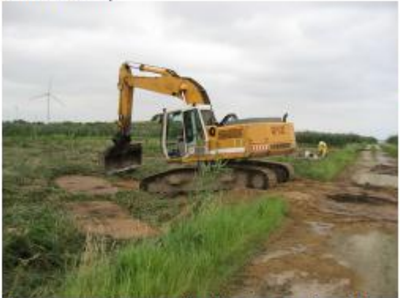
Curage avec descente de l'engin sur des plaques porteuses dans des lits de grande taille (crédit photo Orbicon/Steen Nielsen)
