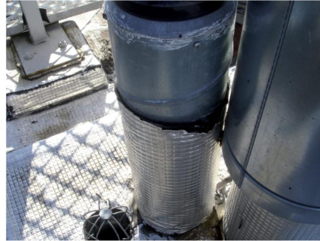
Défaut de traitement des souches de ventilation. Exigüité des points singuliers. Prévoir un dispositif s'opposant au passage de l'eau le long du tuyau, au niveau de la partie supérieure de la pénétration. Veiller à remonter le relevé en butée sous ce dispositif. Vérifier de qui relève la prestation.
