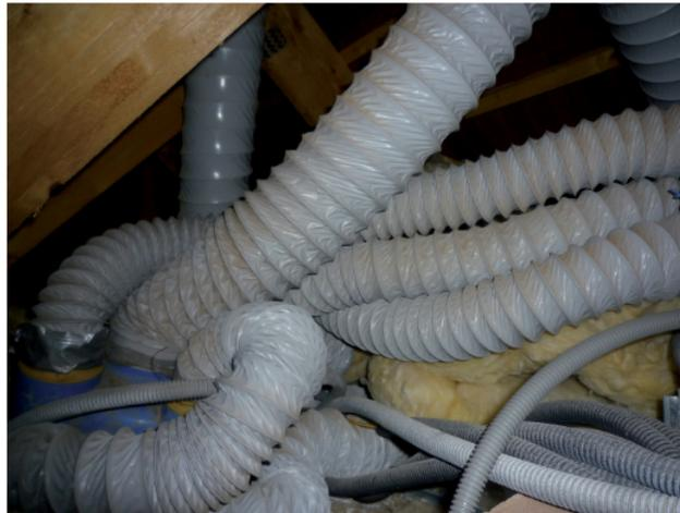
La mauvaise mise en œuvre du passage de gaines en membrane souple PVC, dans les combles perdus, conduit à des écrasements, à des diminutions de sections des gaines et à des points bas. L'air chargé de vapeur d'eau se condense. L'eau s'accumule dans les points bas jusqu'à obstruer presque complètement la gaine. Le débit d'extraction est réduit et le fonctionnement de la ventilation est compromis. Si la quantité d'eau est trop importante, cela peut rompre la gaine.
