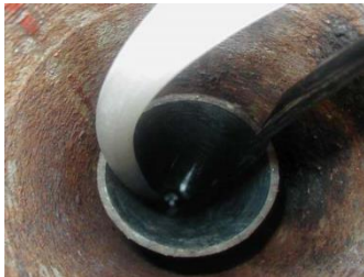
Vue de l'intérieur d'un piézomètres
