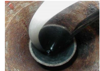
Vue de l'intérieur d'un piézomètres
