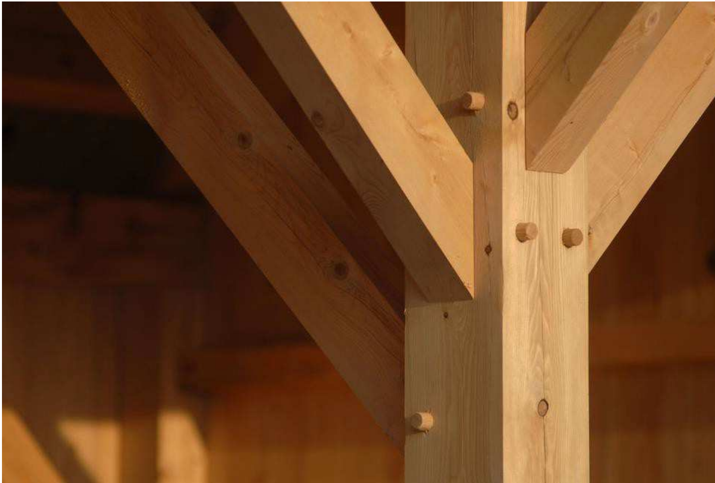
Assemblage par contact bois-bois
