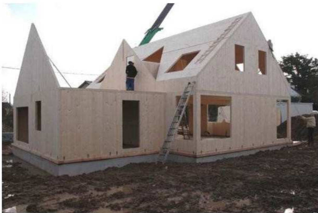
Bâtiments en panneaux massif bois contrecollé
