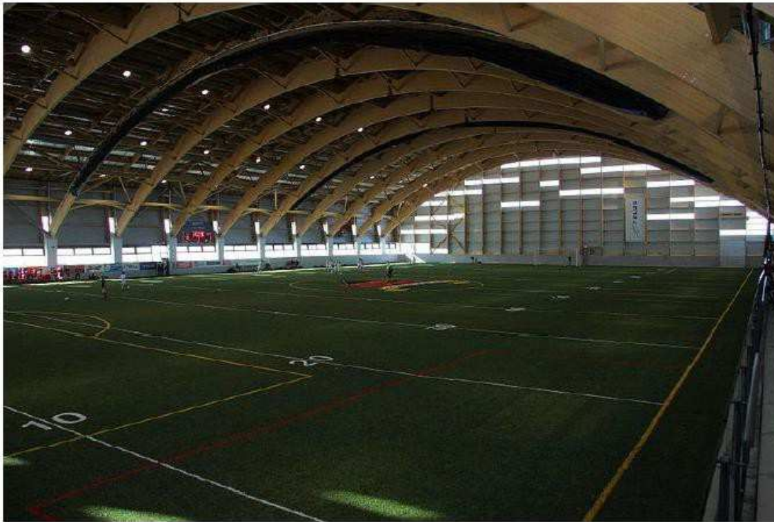
Arcs porteurs en lamellé collé
