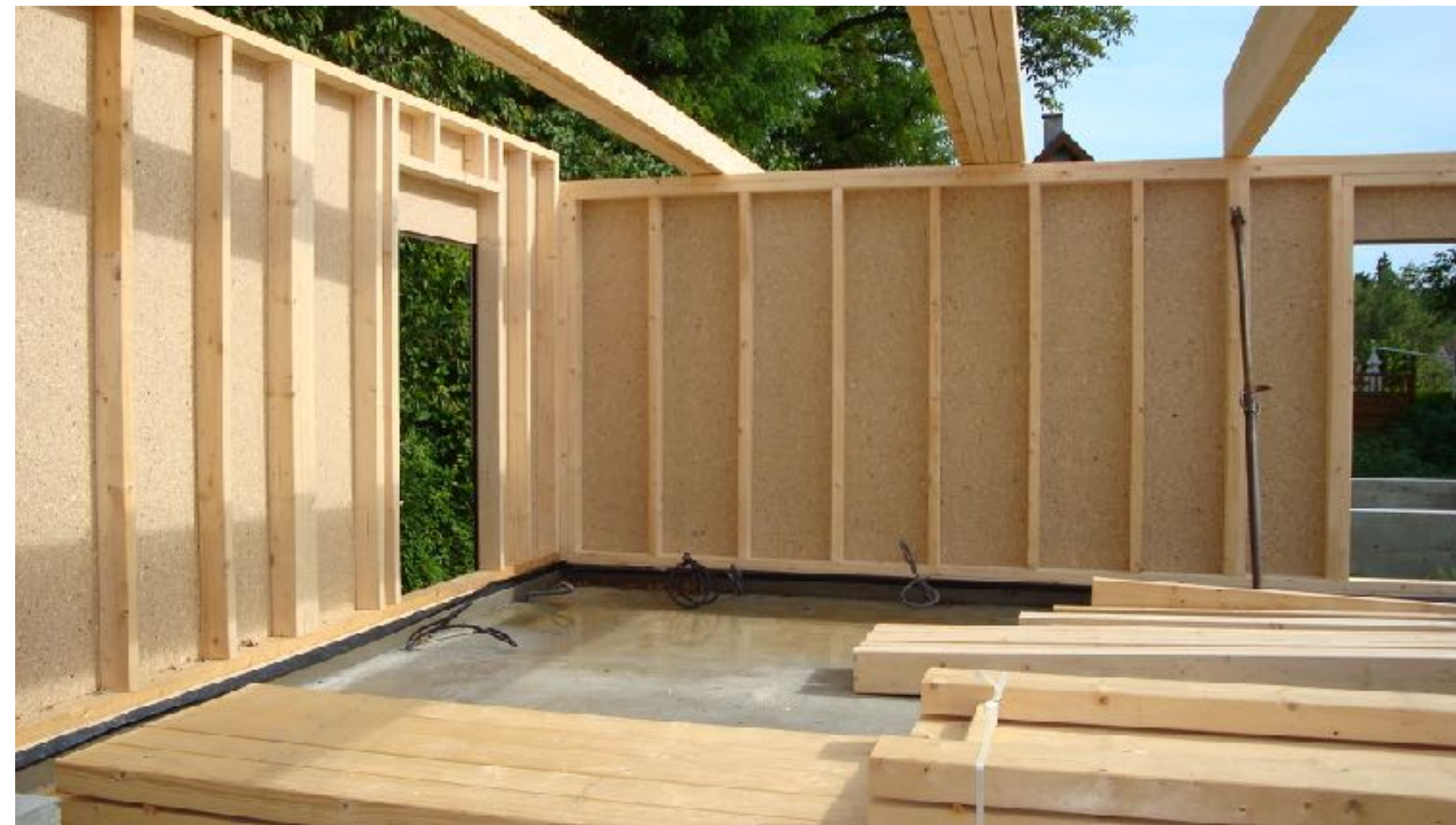
Ouvrage à ossature en bois
