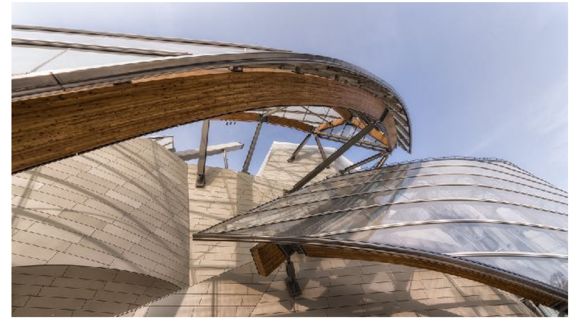
Charpente des verrières en lamellé-collé feuilleté de mélèze, Fondation Vuitton Paris 2013
